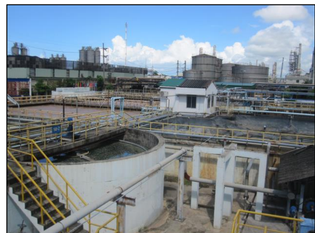
ภาพถ่ายที่ 6 ระบบบำบัดน้ำเสียแบบตะกอนเร่ง
