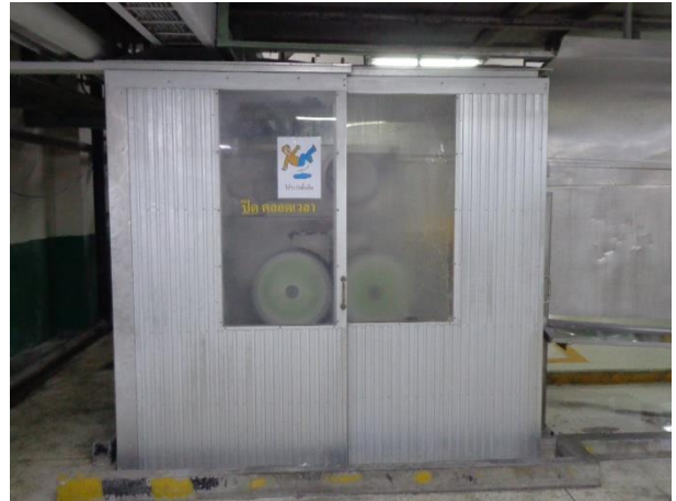
ภาพถ่ายที่ 26 ห้องเก็บเสียงครอบเครื่องจักร
