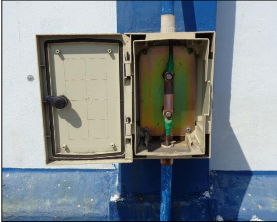
ภาพถ่ายที่ 67 อุปกรณ์ไฟฟ้าต่อลงดิน
