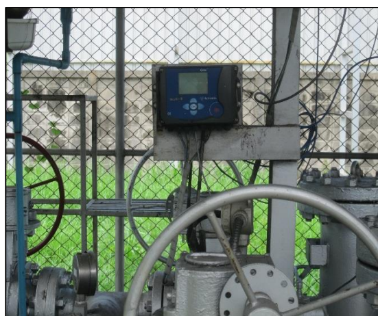
ภาพถ่ายที่ 60 Flow Meter เพื่อวัดอัตราการไหล ของก๊าซธรรมชาติในท่อ
