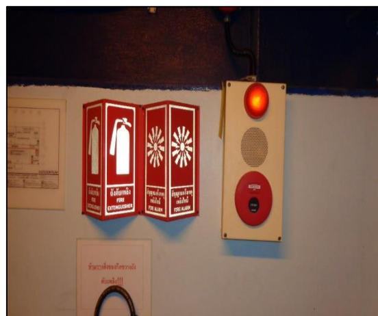
ภาพถ่ายที่ 42 สัญญาณเตือนภัย (Fire Alarm Box)
