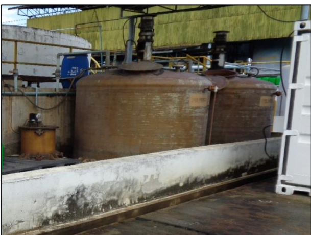
ภาพถ่ายที่ 5 คันคอนกรีตกั้น (Bund) บริเวณลานถังเก็บวัตถุดิบและสารเคมี
