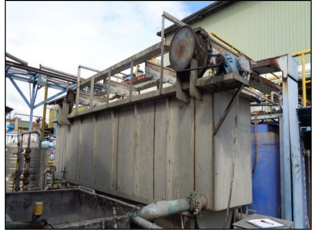
ภาพถ่ายที่ 8 ระบบบำบัดน้ำเสีย แบบ Dissolved Air Floation (DAF)
