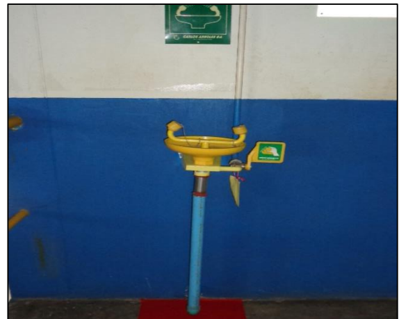
ภาพถ่ายที่ 52 ที่ล้างตาฉุกเฉินในบริเวณที่ พนักงานมีโอกาสสัมผัสสารเคมี
