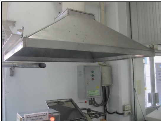
ภาพถ่ายที่ 45 ระบบดูดควันในห้องปฏิบัติการ
