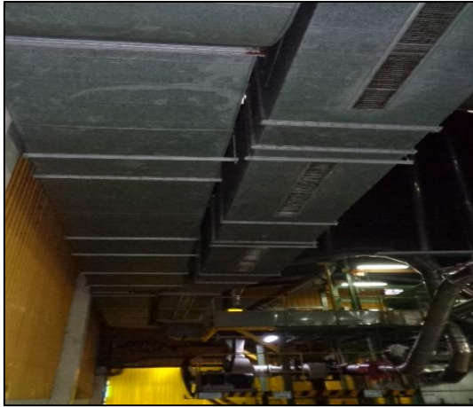
ภาพถ่ายที่ 43 ระบบระบายอากาศเพื่อลดอุณหภูมิ ภายในพื้นที่ส่วนผลิตที่มีความร้อนสูง
